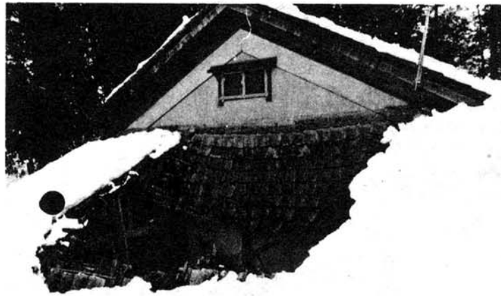
屋根がスッポリ抜ける被害も…… (七日町地内)
