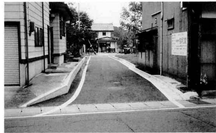
新町3-14・3-16号線 改良舗装
