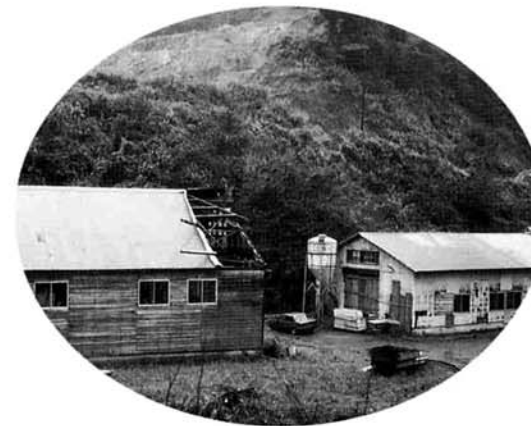
屋根の一部が破損
