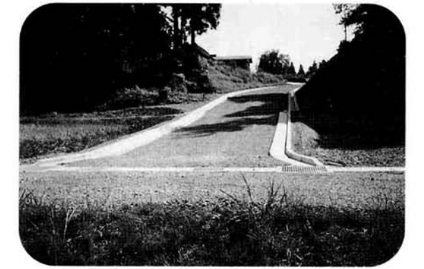
▲原小屋3-6号線 道路改良
