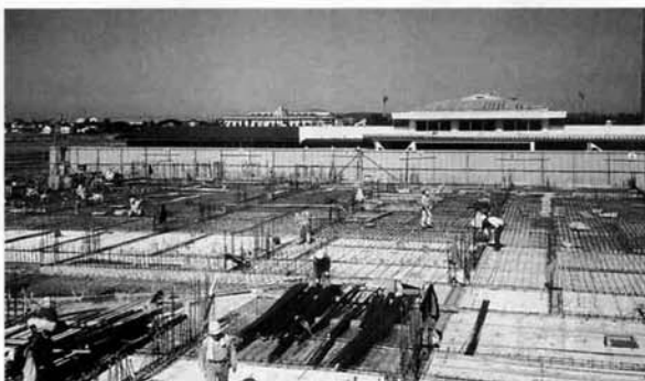
工事が進む斎場
