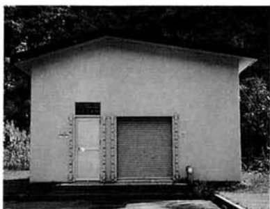
原・森山地区排水処理場
