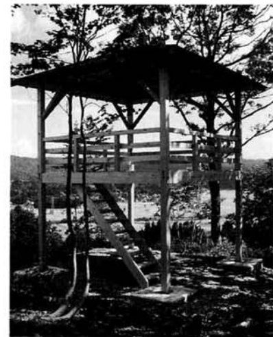
1集落1事業で完成した上村集落「上村山城跡展望台」
