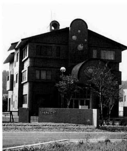
▲昨年完成した浄化センター
