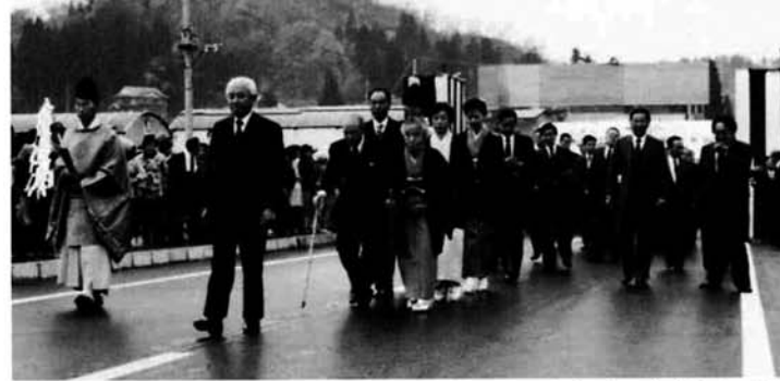
▲450日余りで完成した中曽根橋の渡り初め。この日正午から通行が解放された
