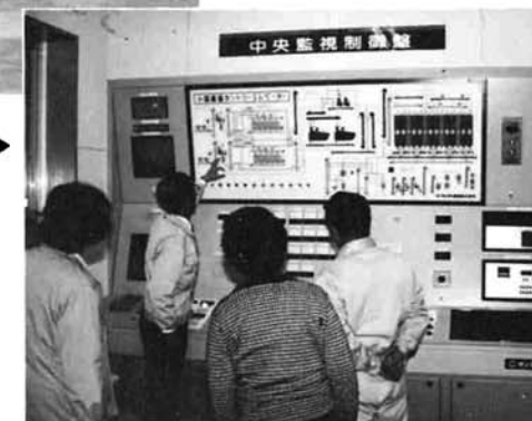
カントリーエレベーターの中央監視制御盤
