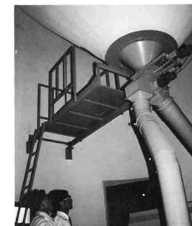
コンクリートサイロ下部 (主サイロ300t×10基) (副サイロ80t×4基)
