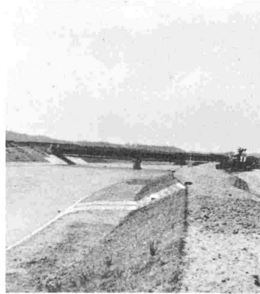
中条地区の猿橋川改修工事現場
