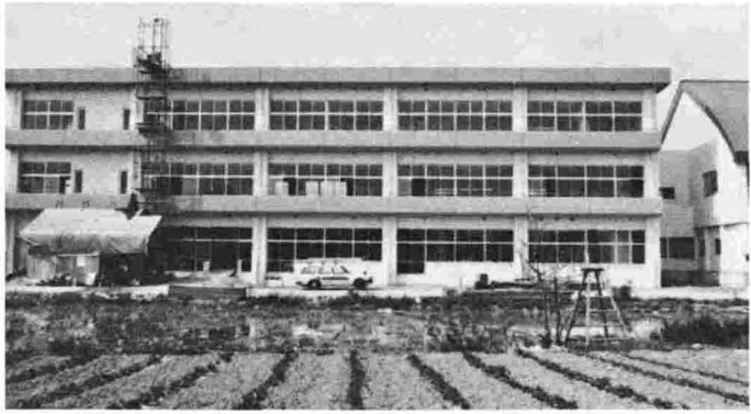
急ピッチで進む上通小新築工事
