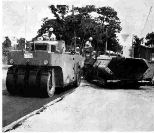
舗装工事も着々と進む
