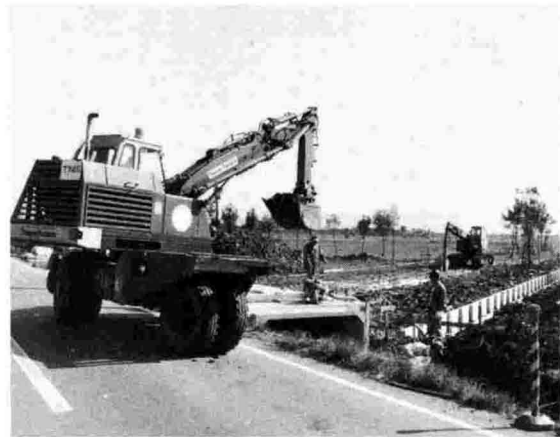
統合校舎建設用地埋立ての乗り入れ道路工事。
