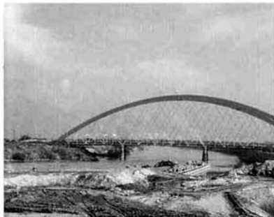
建設が進む本川橋
