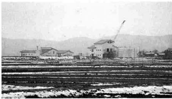
建設が進む「中之島浄化センター」
