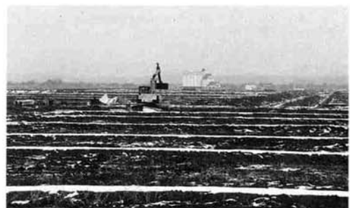
町の重要施策の1つ圃場整備事業 (後方はJAカントリーエレベーター)
