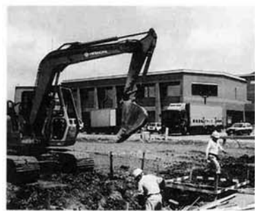
外構工事も順調に進み 備品搬入もはじまりました
