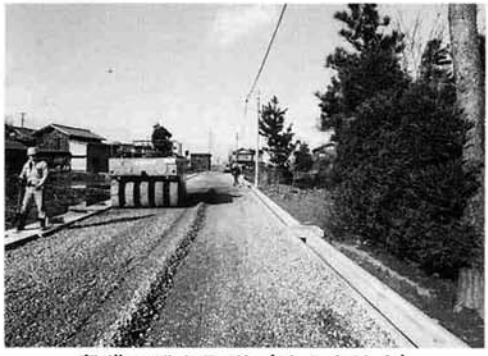
整備の進む町道（池之島地内）
