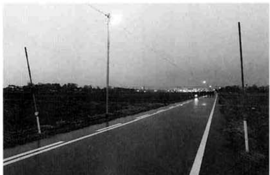
通学路に設置された防犯灯
