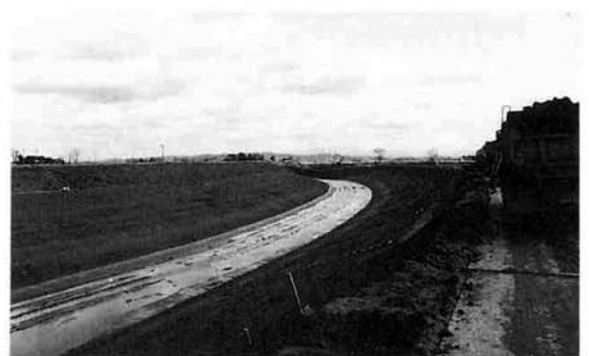
河川改修中の猿橋川
