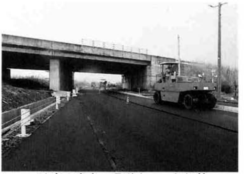
改良工事中の県道大口・与板線
