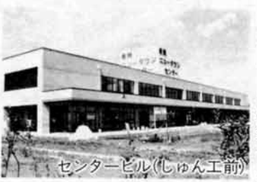
センタービル(しゅん工前)
