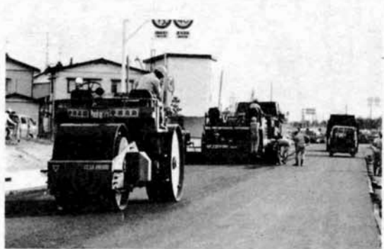
開通を目前に仕上げの舗装工事(中沢町)
