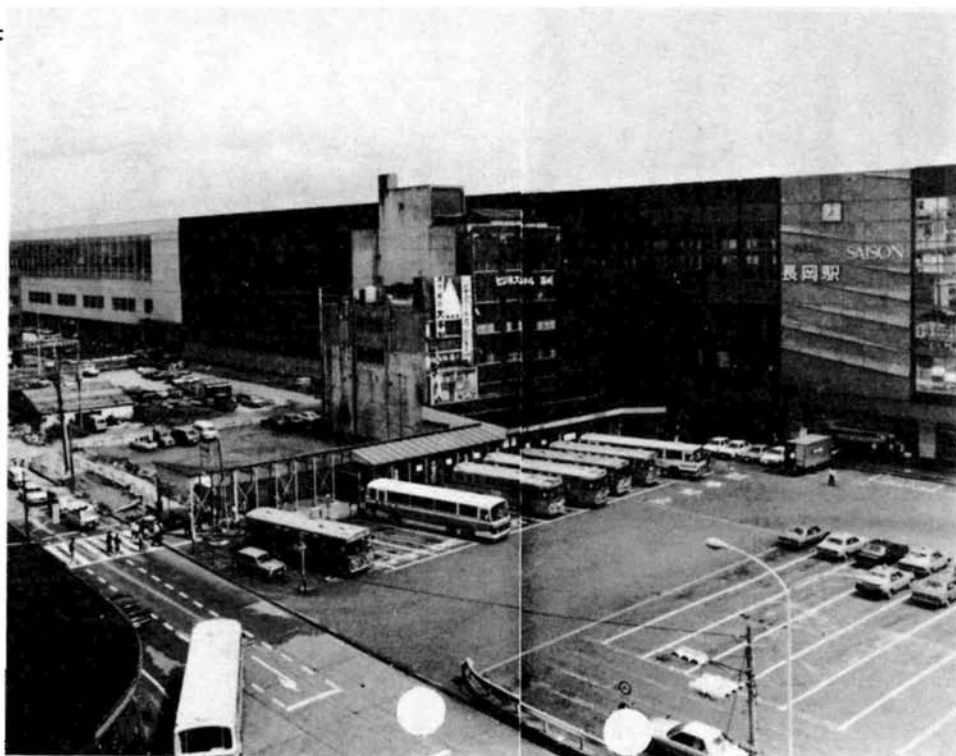
もうすぐ新幹線が開通するのに、大手口広場の真ん中にはまだ二つのビルが立ったまま。(このうち西川ビルは来年度の取り壊しが決まってはいるが…)
