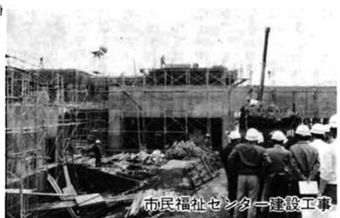
市民福祉センター建設工事
