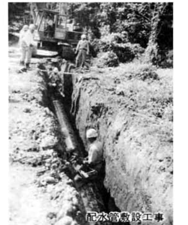
配水管敷設工事
