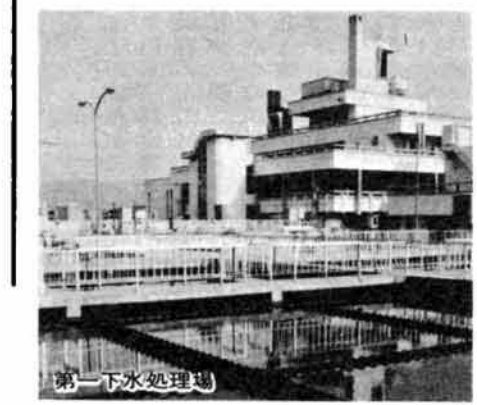
公共下水道の心臓部ともいえる第一下水処理場は、総事業費43億円余りの経費をかけて昭和51年9月に操業開始。現在蔵王処理区の汚水を処理していますが、処理区の拡大によって最終的には14万人の汚水を処理します。
