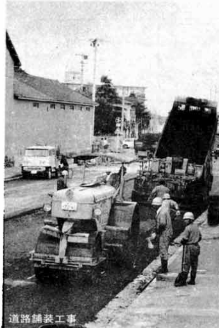
道路舗装工事
