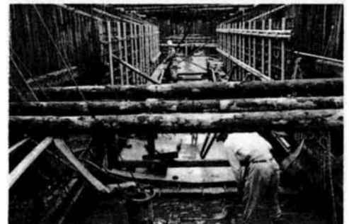
写真1 下水道管きよ布設工事 蔵王排水区
