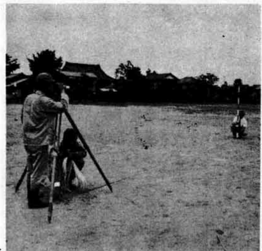
測量中の分譲予定地
