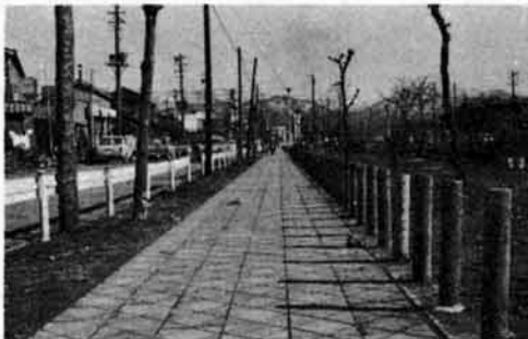
歩道の整備：交通安全のためにも歩道に平板ブロックを敷設します。（整備された柿川緑地帯の歩道）
