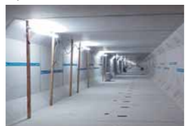
▲工事が進む柿川放水路（内部）
