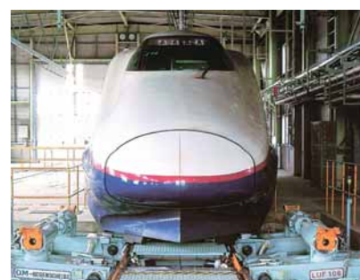
▲車両の下の機械が床下車輪旋盤
