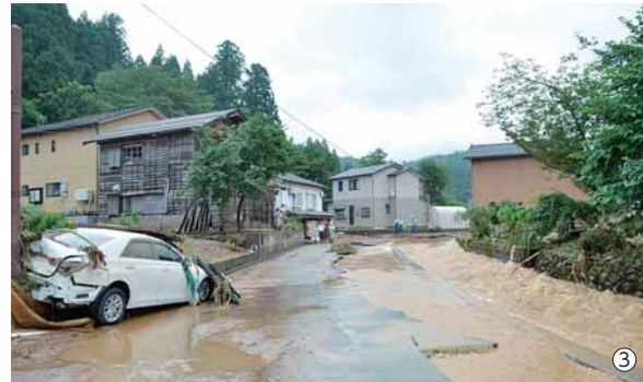
▲甚大な被害を受けた乙吉町の状況 ①がけ崩れが発生した箇所は崩落土砂などを撤去。今後、植生などの法面工事を実施 ②生活道路はおおむね復旧が完了(9月17日) ③豪雨被害直後の様子(7月30日)
