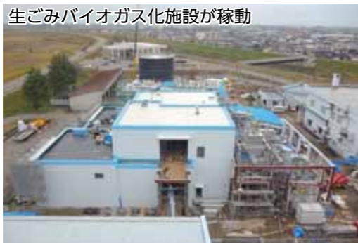
生ごみバイオガス化施設が稼働 全国最大規模の施設が7月に稼働。生ごみを微生物で分解処理し、発生するバイオガスを発電に利用します。年間発電量は410万kw(一般家庭の約1,000世帯分)
