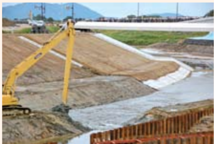
▲重機が土砂を取り除き、通水が始まりました
