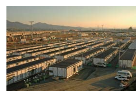
▲震災から2カ月後、仮設住宅が立ち並ぶ千歳の長岡操車場跡地（上）。現在は市の新たな防災拠点「長岡防災シビックコア」の開発が進む（右）。消防本部庁舎、市民防災公園などを集積し、平成22年度に完成予定
