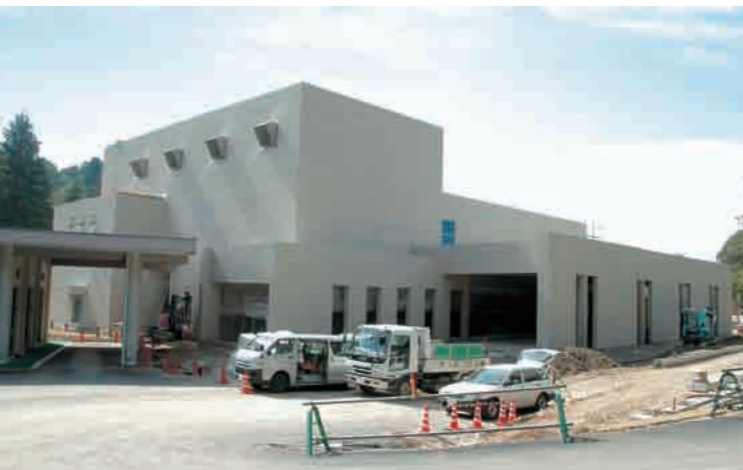
▲11月の稼働に向け急ピッチで工事が進む新しい長岡市斎場
