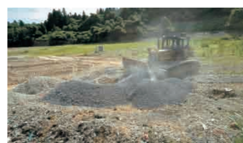
▲5つの埋立地の一つ、鳥越クリーンセンターの最終処分場。昨年1年間で燃やすごみの焼却灰や破碎した燃やさないごみなど9,394㎡（25mプール約23杯分）が埋め立てられました。
