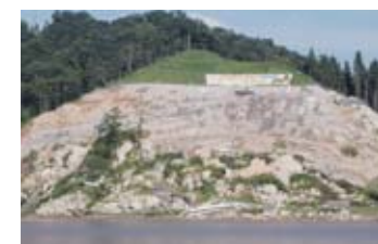
▲県道の復旧工事が進む妙見町の土砂崩れ現場
