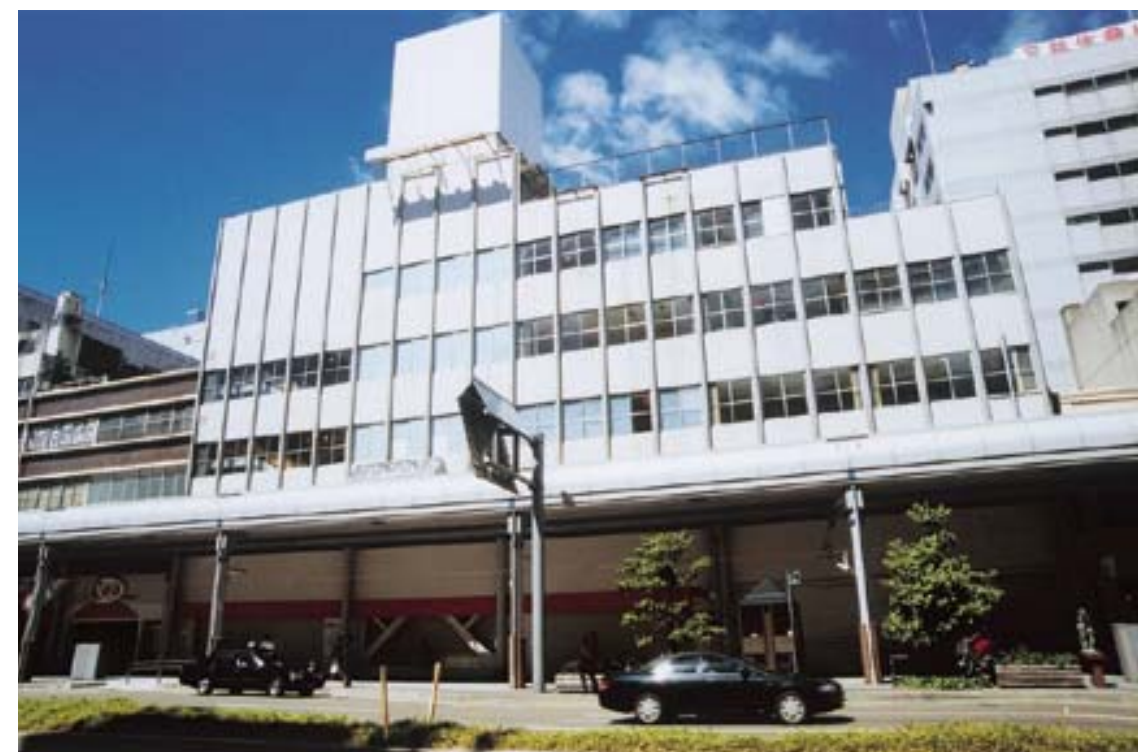
「ながおか市民センター」がオープンする旧ザ・プライス丸大ビル 現在、急ピッチで内部の改修工事が行われています。
