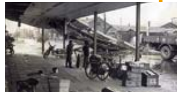
第2室戸台風で被害を受けたアーケード(城内町)
