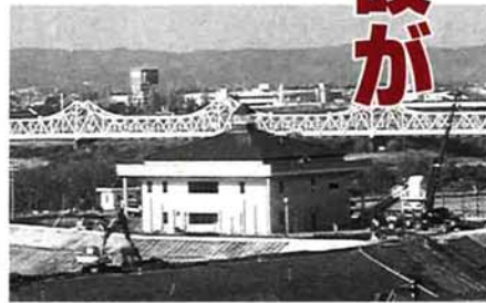
▲モダンな建物のポンプ場（左近町）
