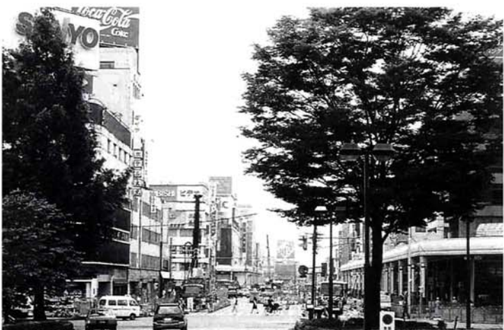
大手通りで進められている地下駐車場、シンボルロード整備、アーケード建て替えの三つの大工事。市民のみならず、大変なご不便をおかけしています。新しい装いに生まれ変わるまで、もう少しの間、ご理解、ご協力をお願いいたします。
