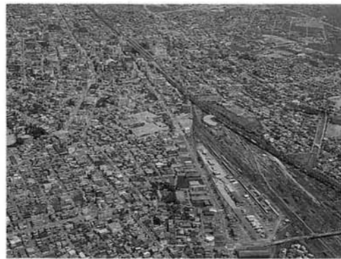
▲地方拠点都市の開発整備の核の一つとなる「長岡操車場跡地地区」。長岡地域では、このほかに5つの拠点地区を重点的に整備します。
