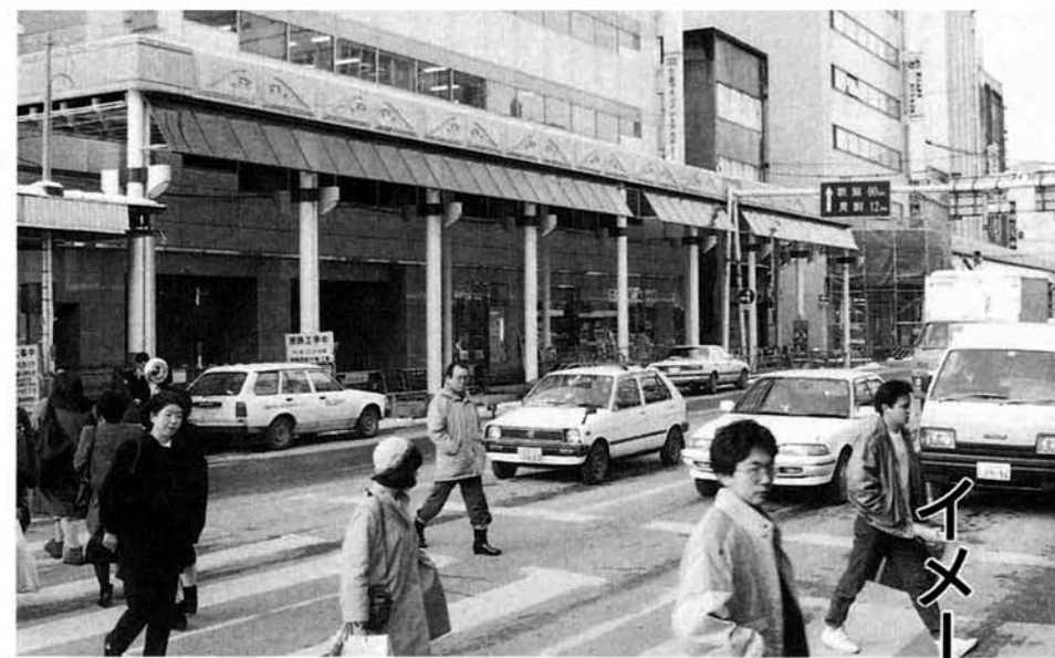
▶工事中のスズラン通りアーケード
