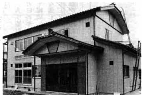
完成した 新保集落開発センター
