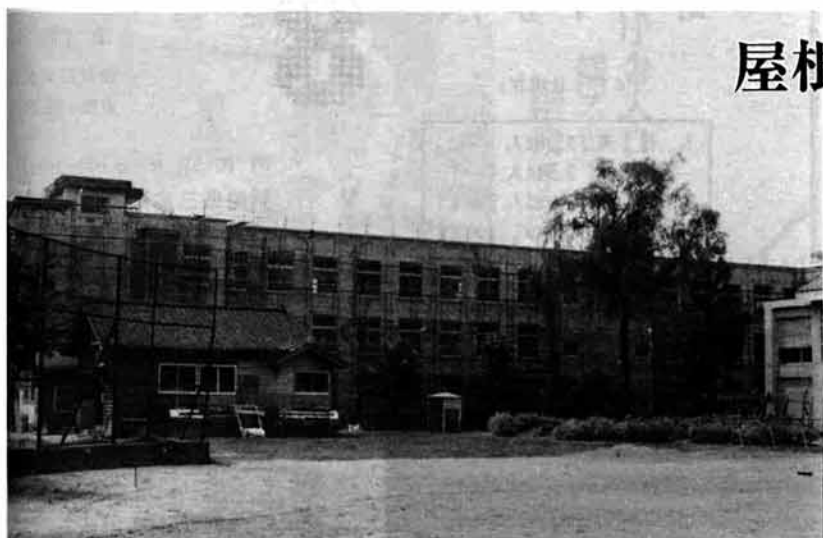
生れかわる脇小校舎(北側から写す)
