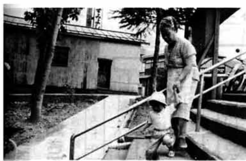
庁舎入口に 緩スロープと 階段手すり
