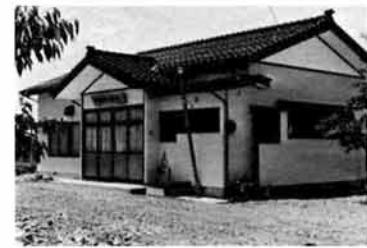
完成した脇野町生活改善センター
