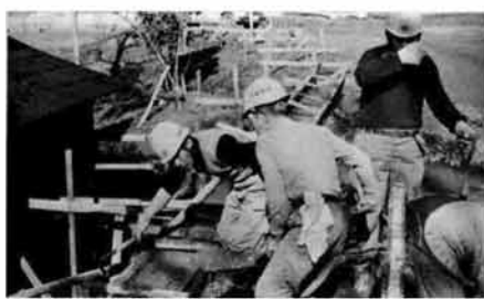
気比宮長村線の町道改良工事
