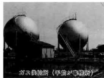
ガス供給所（手前が専用所）
