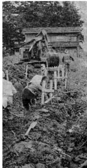
瓜生中線改良工事
