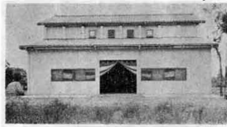
(竣工した農協倉庫)
