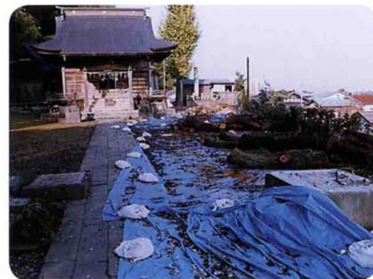
▲日出神社 鳥居や灯籠などが倒壊。石垣の斜面側に立っていた桜の木は、危険防止のため切られた。
