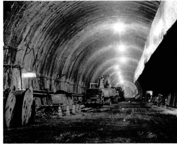
切羽と土砂の運び出しが行われる上半
