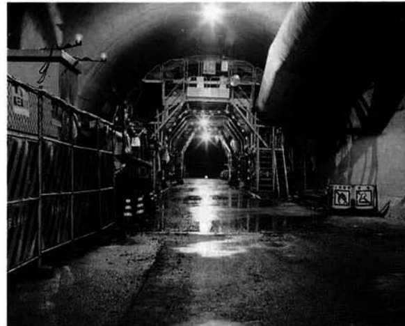
シート張足場を置き、アーチを形づくる
