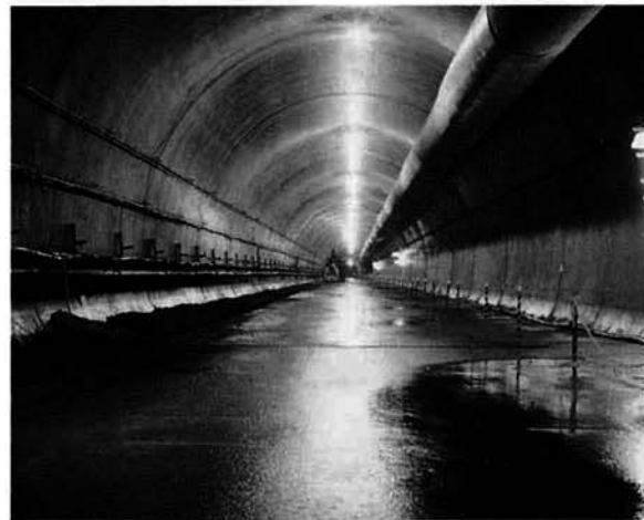
コンクリートが吹きつけられ簡易舗装された下半
