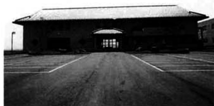
■農村環境改善センター■ 郷土資料館との合築で「みしま中央会館」とネーミングされました。
