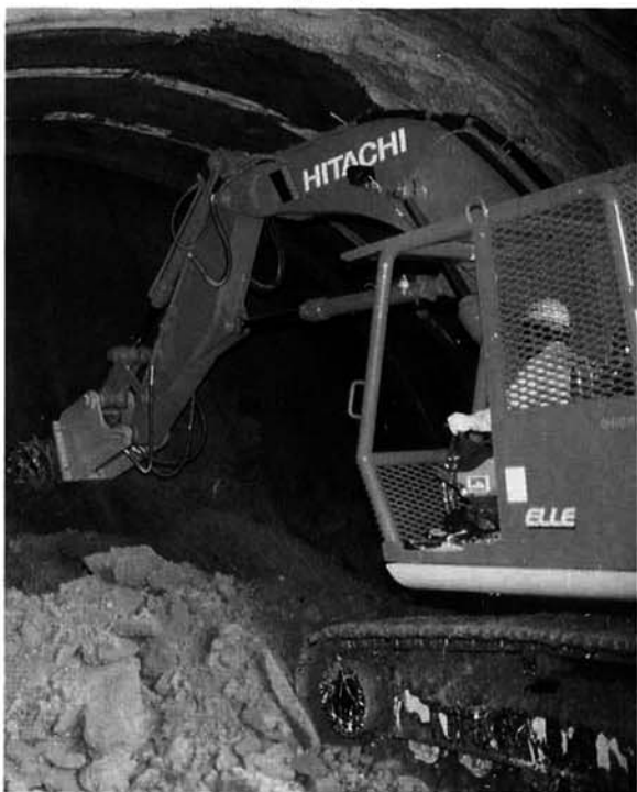
▼掘削するのは「ツインヘッダー」といわれる建設機械
