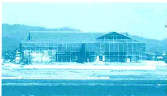
順調に進んでいる農村環境改善センター建設工事。
