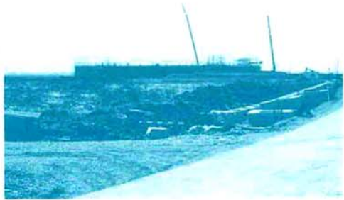
区画地区内の幹線道路の拡幅工事が始まっています。北銀体育館は11月のオープン予定。
